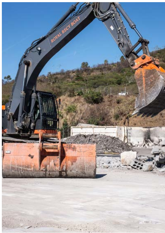
Les chantiers de démolition ont débuté mi-juillet dans le Grand Nouméa.
