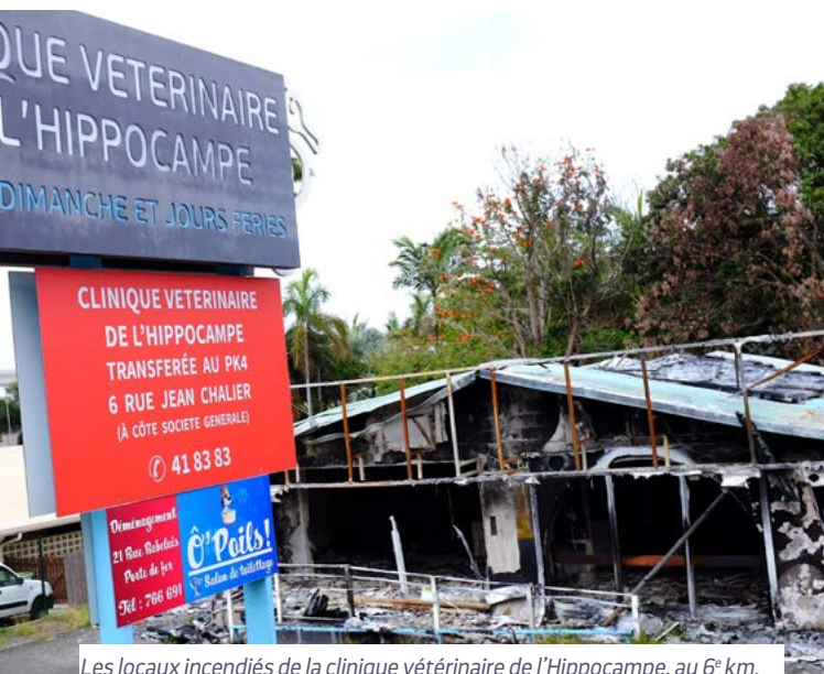
Les locaux incendiés de la clinique vétérinaire de l'Hippocampe, au 6 e km.
